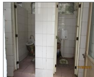
External photo(s) of the production unit(s) Toilet.JPG
